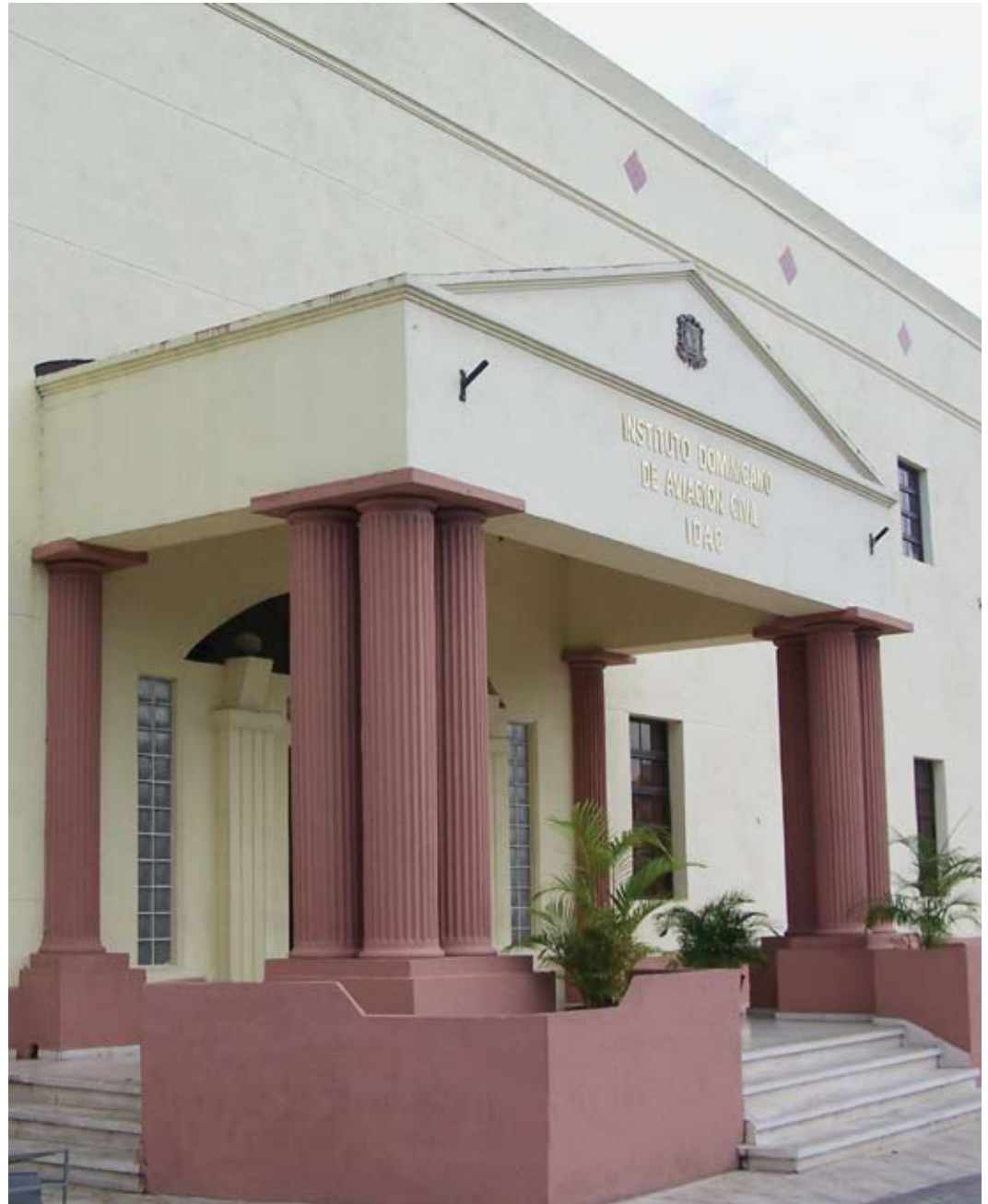
Fachada de uno de los edificios del Instituto Dominicano de Aviación Civil, (IDAC), ubicado en la Avenida México esquina avenida 30 de marzo.
